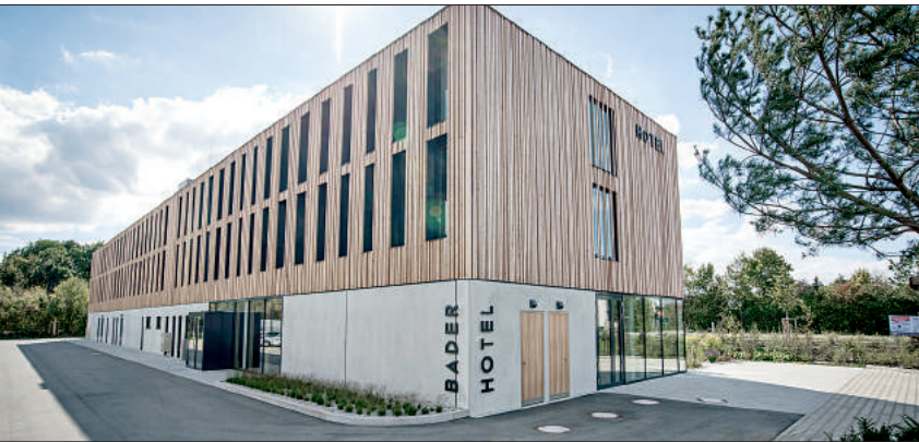
Das neue Bader Hotel in Parsdorf bei München ist ein Holzbau, der aus Raummodulen zusammengesetzt ist. Fotos: Bader Hotel (2)
