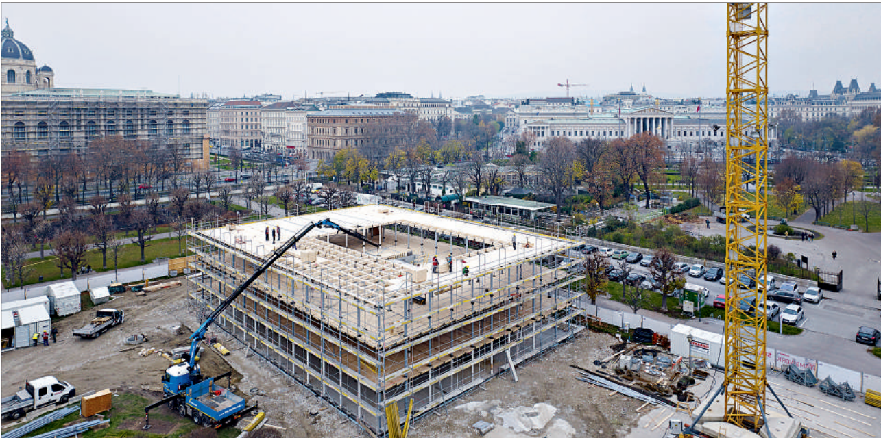
Zwei der drei Büro-Ersatzgebäude für die Parlamentsmitglieder stehen auf dem Heldenplatz in Wien. Dem Holzskelett der Dreigeschosser liegt ein Baukastensystem aus Brettschichtholz-Stützen und -Trägern sowie Deckenelemente aus Brettspertholz zugrunde. Foto: Lukas Lang Building Technologies
